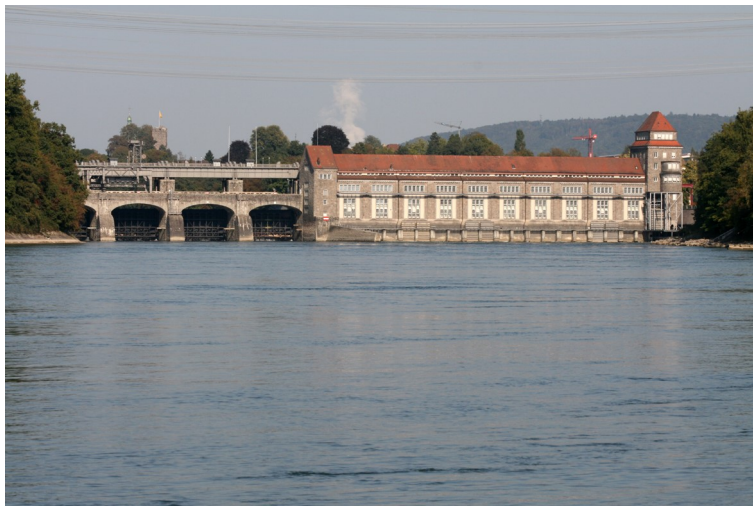
Fig.1. Flusskraftwerk bei Laufenburg
