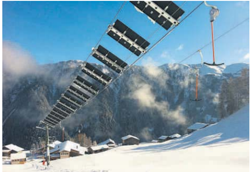
Der Skilift in Tenna mit den in acht Metern Höhe über der Schlepplift montierten sogenannten Solar-Wings.
