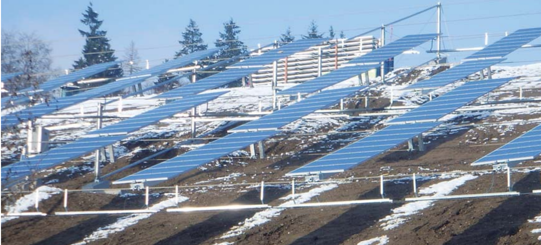
Solar Wings einachsiges Nachführsystem mit 650kW Nennleistung wurde im Dezember 2008 in Waldshut, Deutschland in Betrieb genommen (Projektteam: Solar Wings, Bartholeth AG, ZHAW, Lonza Group, Stadtwerke Waldshut) Auf einem Modulträger sind acht polykristalline Sunways Module mit einer Nennleistung von je 220Wp installiert.
