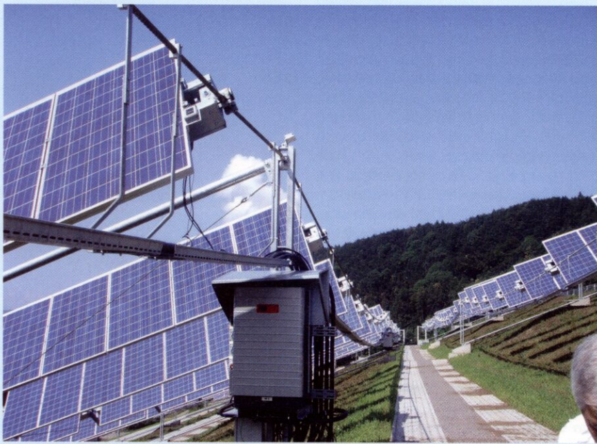
5 Die Wechselrichter sind im Feld installiert, der Kabelkanal wird am Tragseil mitgeführt
